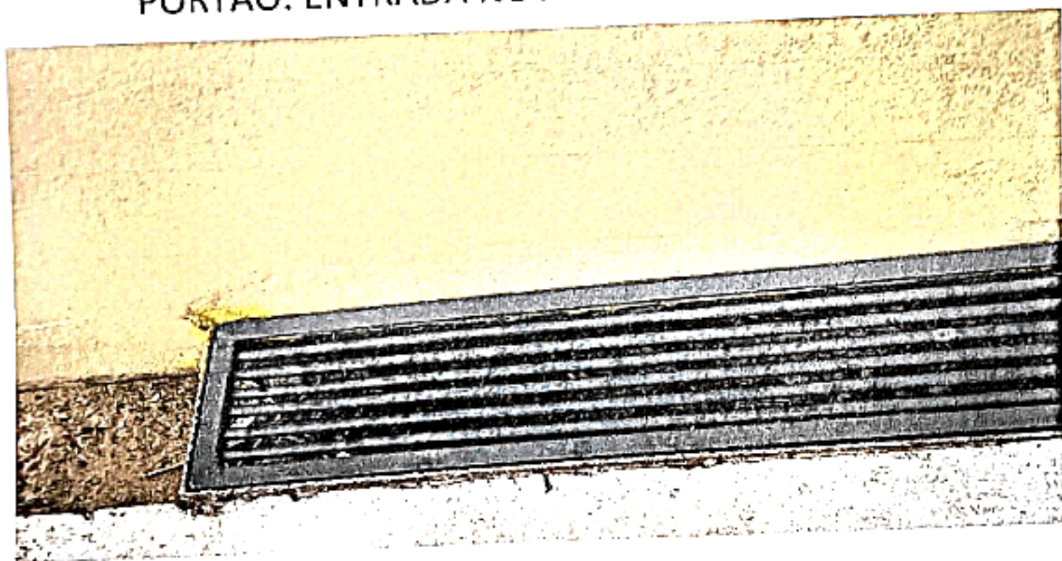
COLOCAÇÃO DAS GRELHAS NOS RALOS
